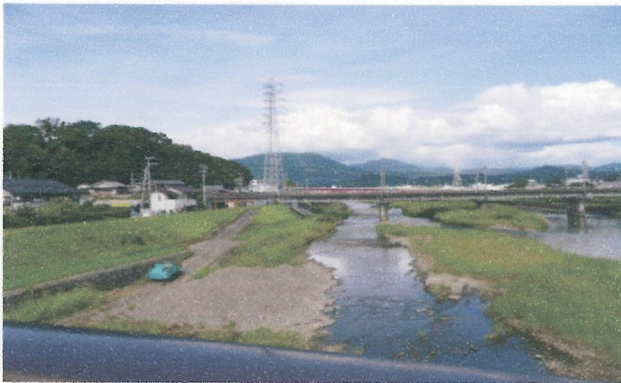
会津川からの全景（切戸橋より）
