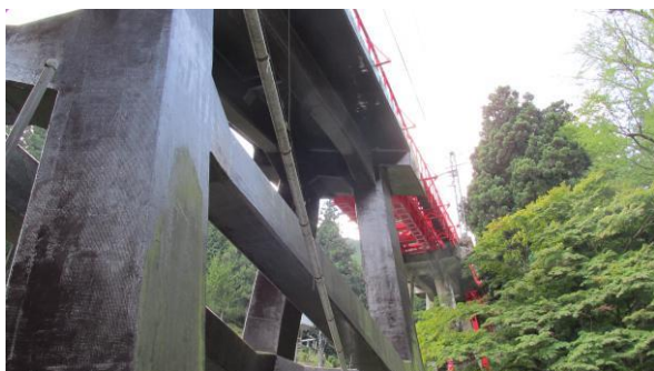
ケーブルカー滝本駅先の橋脚と橋梁
