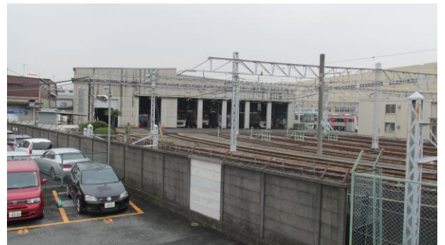
都営地下鉄操車場
