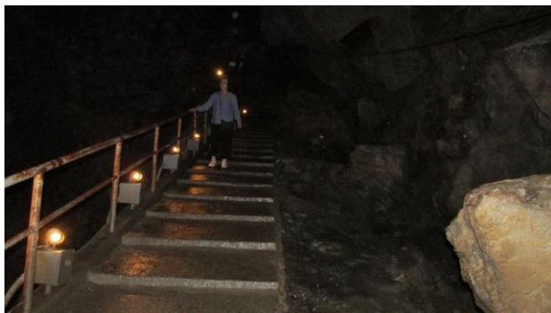
ところどころに段差解消用の鉄骨階段が
