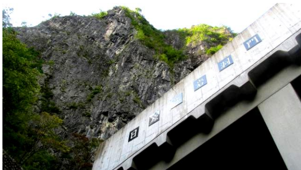
日原街道洞門と石灰岩の岩山
