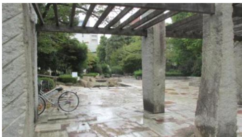
線路南側の荒川公園のパーゴラ
