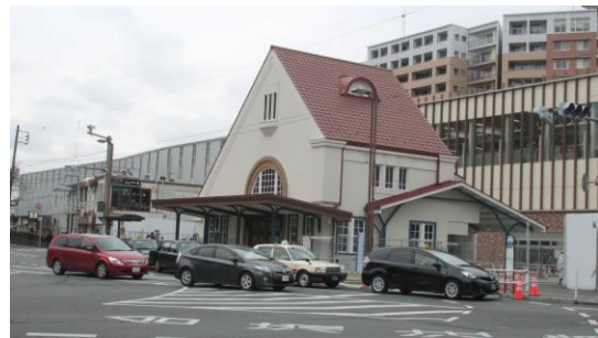
国立駅旧駅舎の修復ほぼ完了 4 月 4 日開場予定
