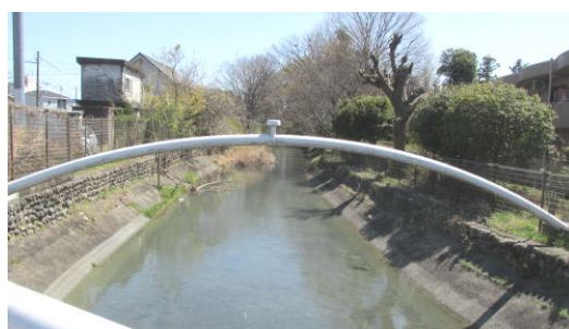
羽村取水口から流れる玉川上水を新橋で跨ぐ
