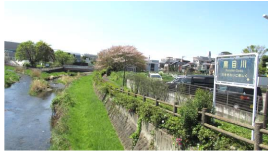
左側が落合川・右側は黒目川本流 ここから再び上流へ
