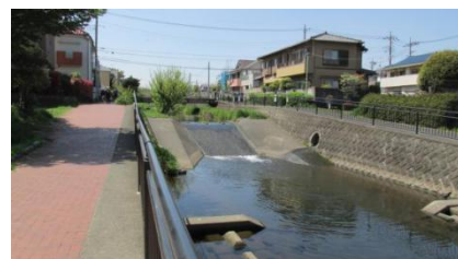
川の段差解消？
