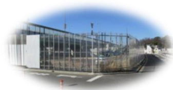
三鷹市内では高速下工事中
