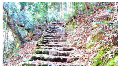
休憩所へと上がる急な階段：約30mの高低差
