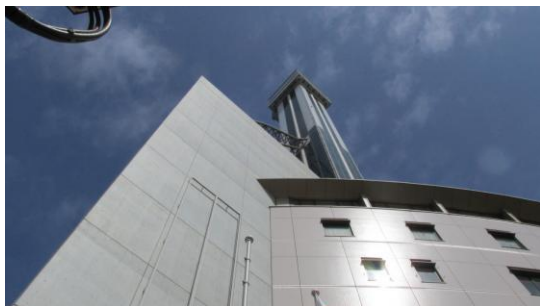
タワーホール外観
