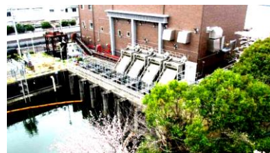
中川との水門
