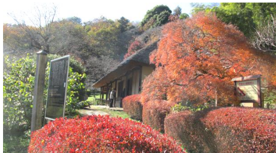
古民家を移築しているが、かなり荒れて
