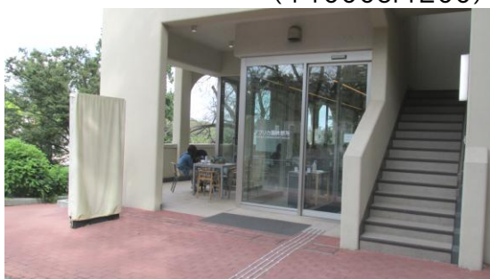
キリン南側の休憩所(裏口)
