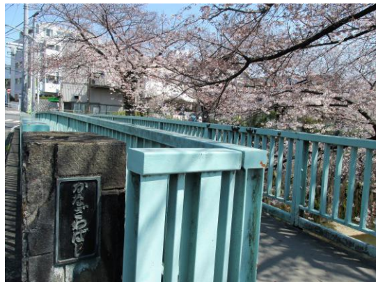
加賀公園東詰の金沢橋
