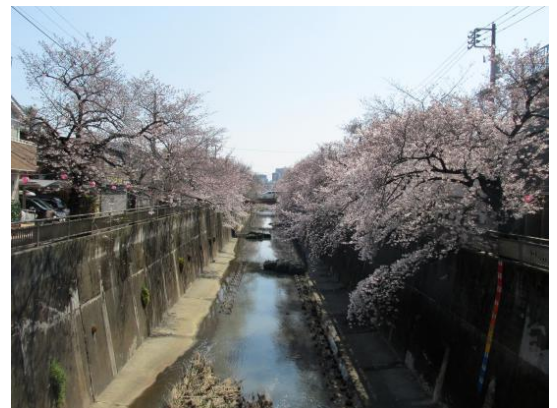
中板橋～下流方向を見る
