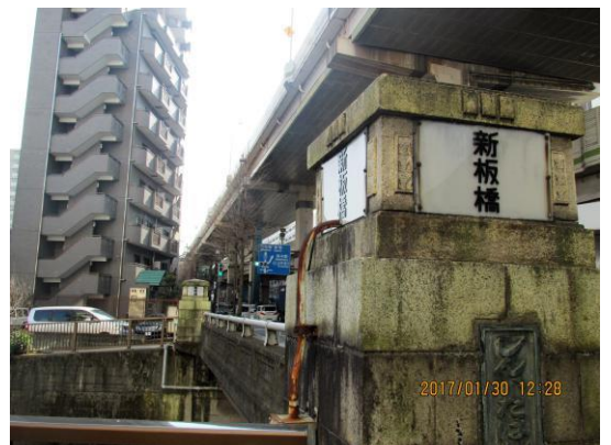
新板橋＝国道 7 号とクロス
